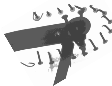
写真6 シートタックスでかしめ固定
