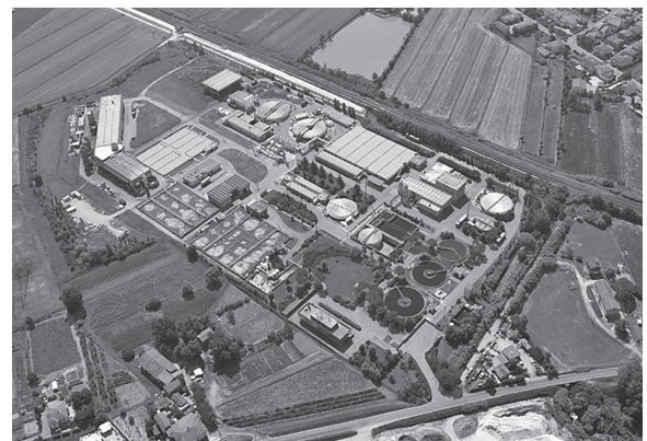
クオイオデプーラ排水処理場の全容
