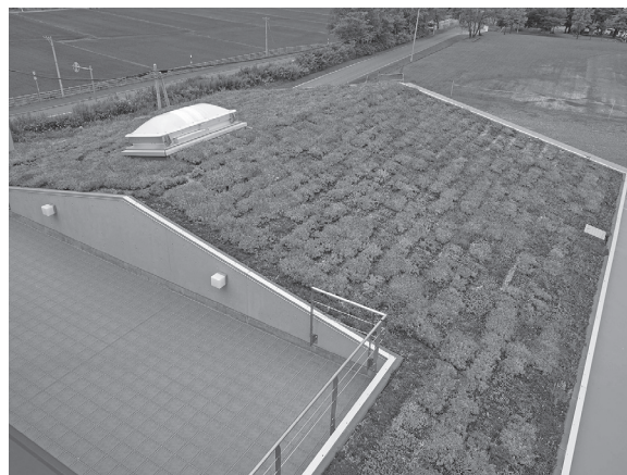
緑化された屋上
