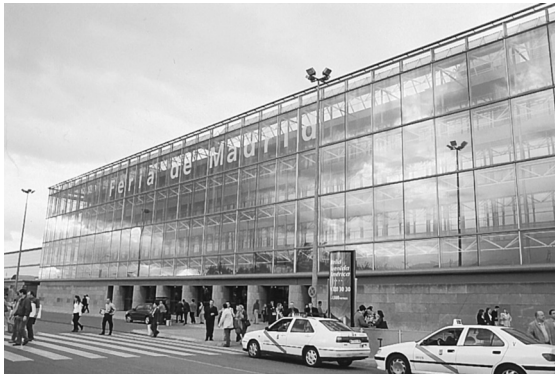
モーダ・カルサードが行われるマドリッド郊外にある見本市会場
