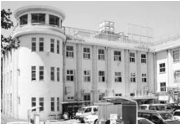
施設全景：台東デザイナーズビレッジは旧小島小学校校舎を活用
